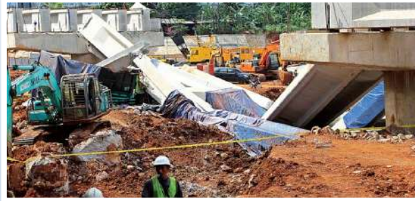
Beton girder proyek Jalan Tol Depok-Antasari, Jakarta, Selasa (2/1/2018)
