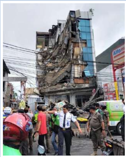
Runtuhnya Bangunan Gedung Mid-Rise di Slipi, Jakarta, Senin (6/1/2020)
