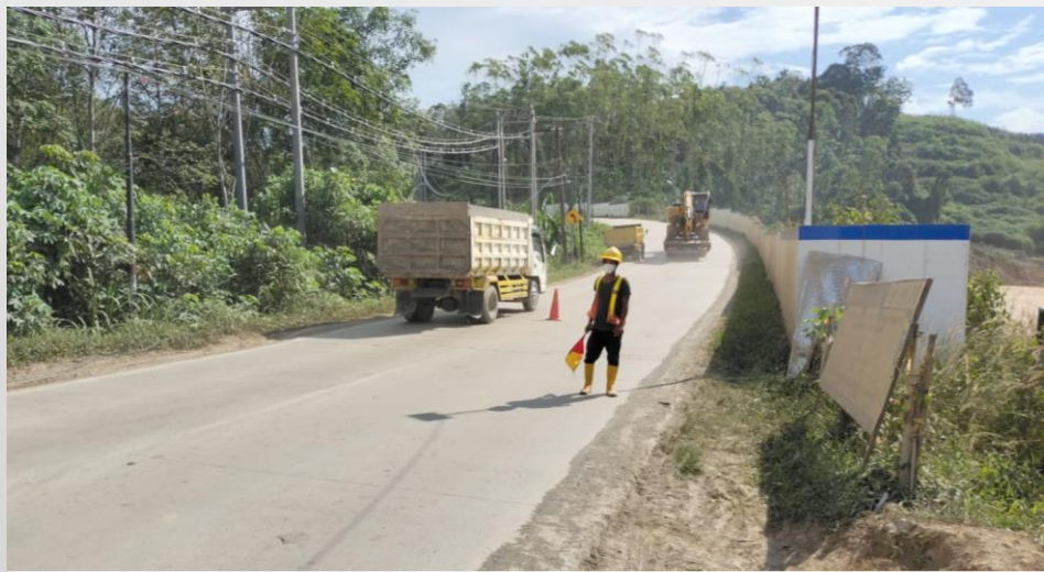
Penempatan flagman pada akses keluar-masuk proyek
