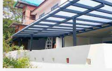
Pemasangan Atap Plycarbonate
