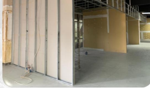
Pemasangan baja untuk rangka partisi
