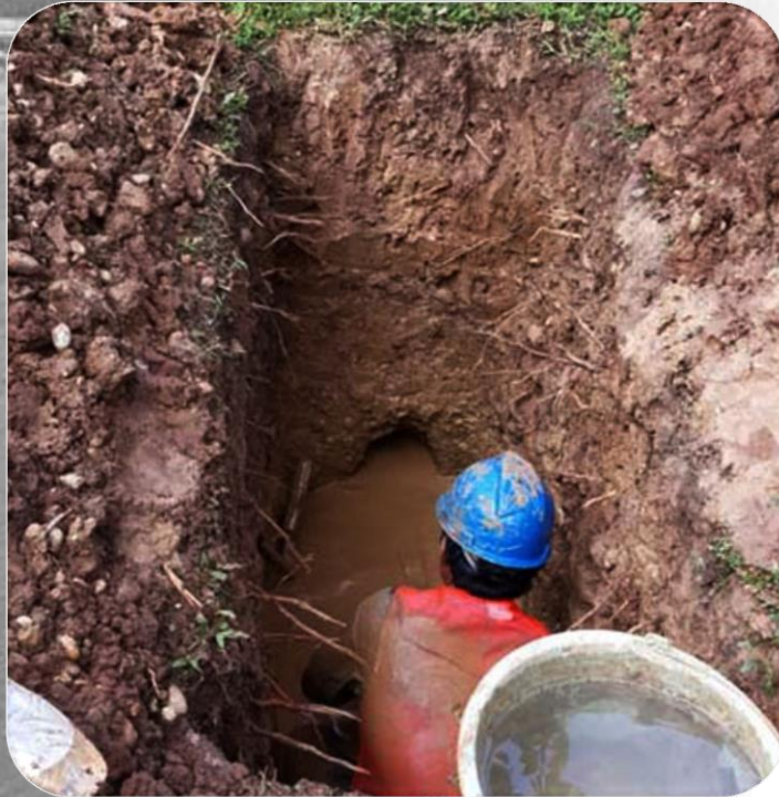
Pekerjaan Bor Pipa Manual
