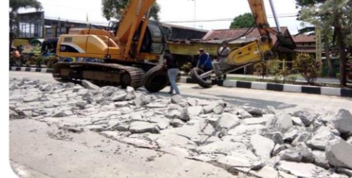
Bongkar Beton dan Pengangkutan
