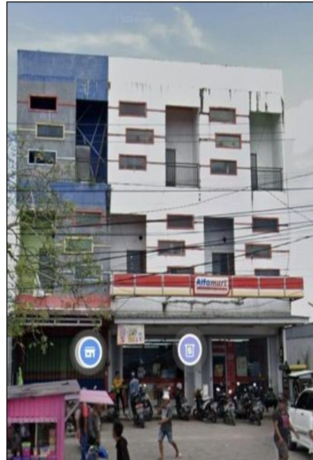
KONDISI BANGUNAN ALFAMART SEBELUM KEGAGALAN BANGUNAN
